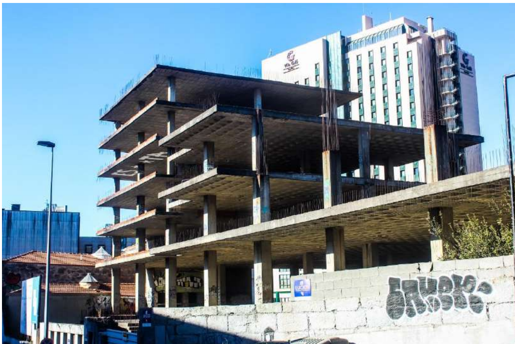
Edifício onde Gisberta morreu, no Porto. Foto: Sofia Matos Silva
